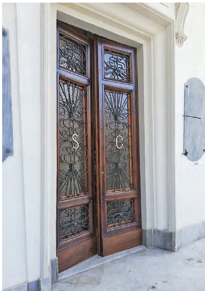
Portone centrale d'ingresso
