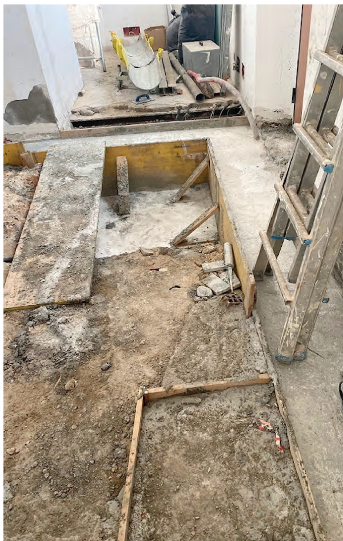
Piano terra durante i lavori per il superamento dei dislivelli presenti
