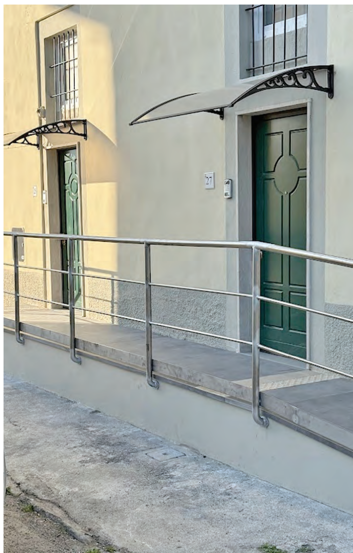
Ingresso da via Don Aldo Mei con la rampa per il superamento delle barriere architettoniche
